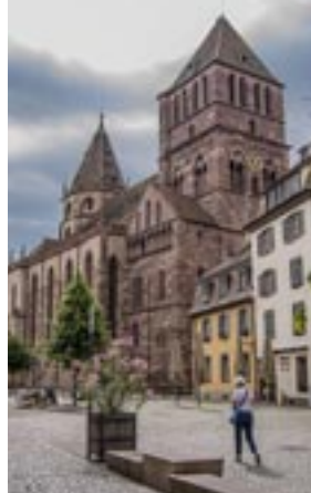
Fig. 1 Die Thomaskirche in Straßburg Chiesa di San Tommaso a Strasburgo Foto: Stefano Merli
